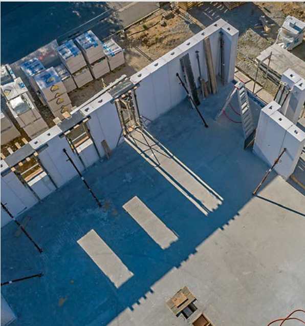
Grossformatige Systemwandelemente (SWE) kommen für Aussenwände, Trennwandelemente (TWE) für tragende Innenwände zum Einsatz.
