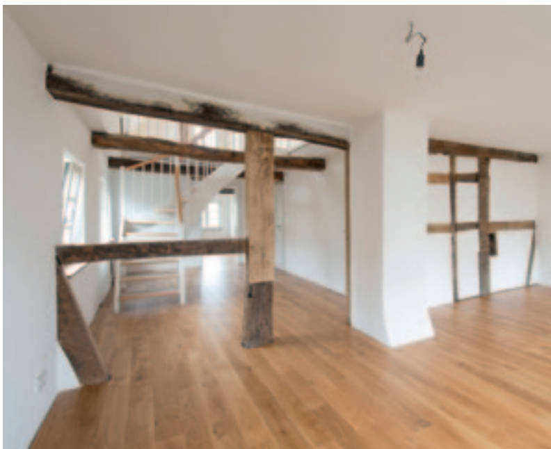
Rénovations flexibles de maisons à colombages avec du béton cellulaire Ytong
